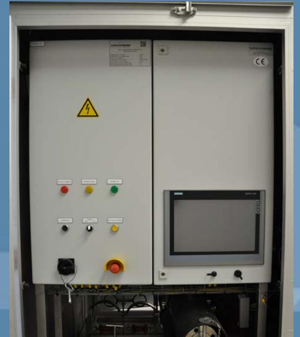
Meß- und Steuerschrank zur Datenerfassung und Speicherung
