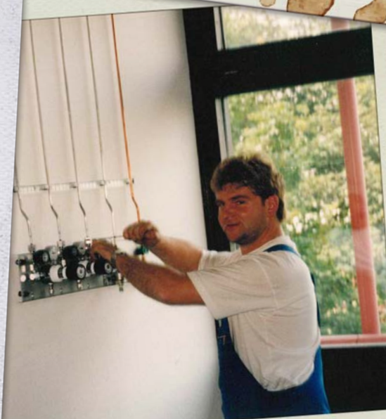
Helmut Janning beim Bau einer Laborgasversorgung
