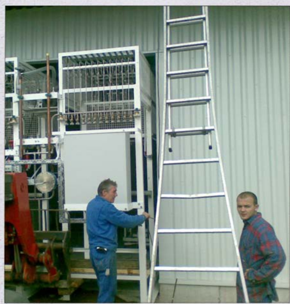
Bau Füllwerk Westfalen Gas, Torcy, Frankreich 2007, Millimeterarbeit! Die vorgefertigten Füllstände passen gerade so durch das Hallentor
